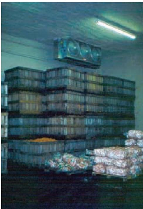
**Figure 53:** Intérieur d'une chambre froide. L'évaporateur est situé en haut de l'un des murs.
