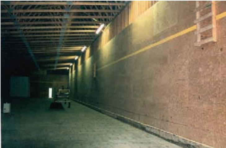
Figure 51: Lieux de stockage à circulation d'air forcé. Le produit est empilé jusqu'à la ligne jaune. L'air provenant des ouvertures au sol est forcé de passer au travers des masses stockées. Une allée d'inspection est située en haut à droite, avec des échelles afin d'échantillonner le produit pendant le stockage.
